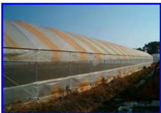
Evidenti depositi di sali ferrosi nell'area di transito dell'acqua
