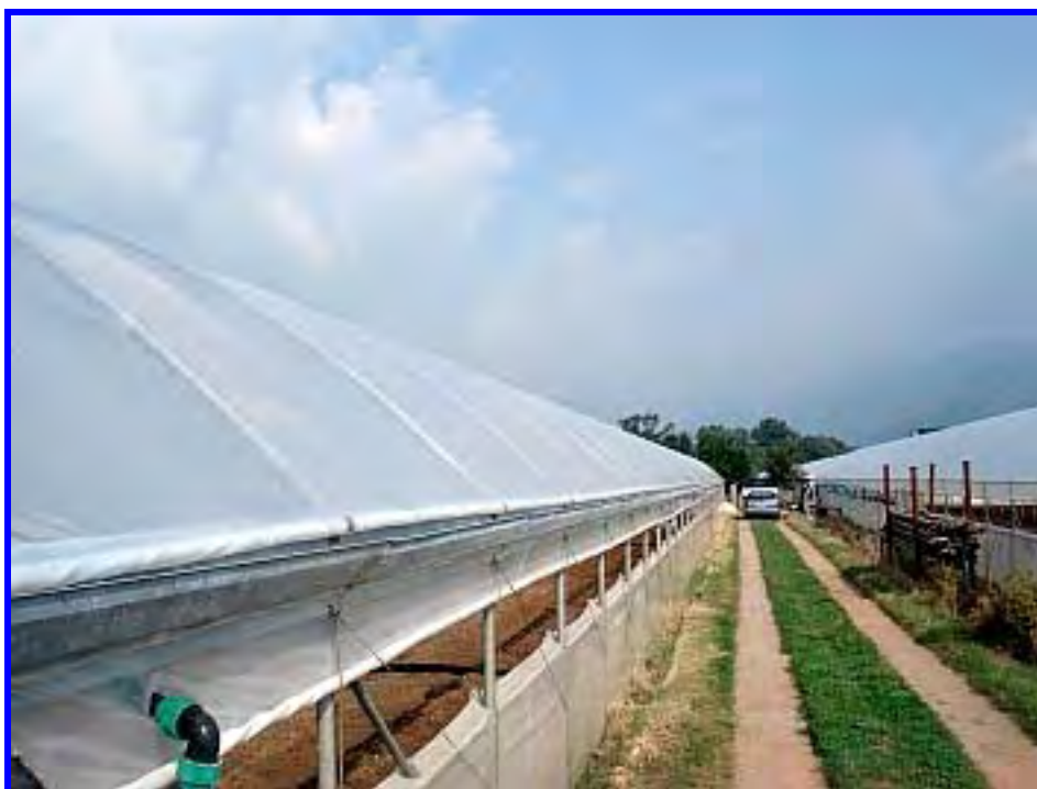
Idroserra: la serra 1 (a sinistra) è stata dotata di grondaia per il recupero acqua, mentre la serra 2 (a destra) rimane nelle condizioni ordinarie
