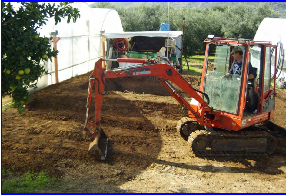
Idroserra: scavo della vasca per il recupero dell'acqua
