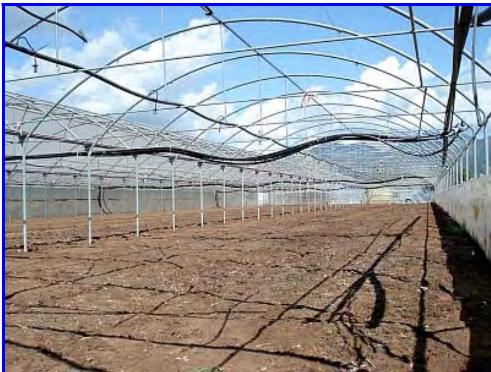
L'interno della struttura dimostrativa il 17.09.09 prima dei lavori di adeguamento
