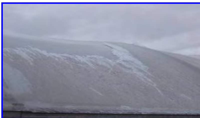
Formazione del ghiaccio con temperatura aria esterna prossima a 0°C
