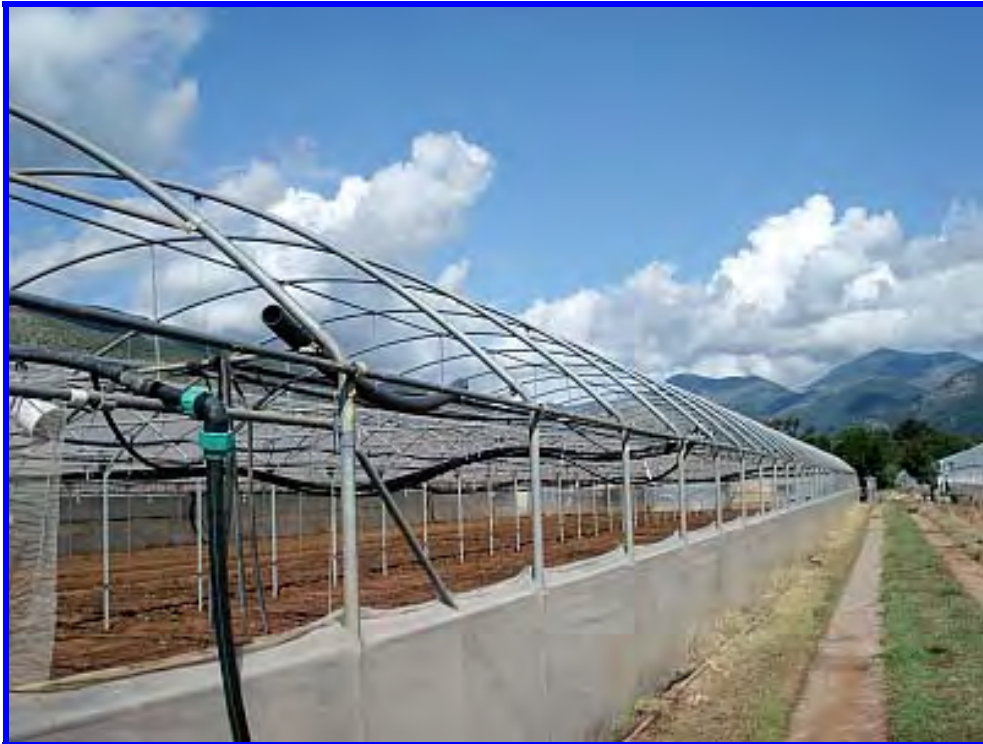
Esterno della struttura dimostrativa (serra 1) il 17.09.09 prima dei lavori di adeguamento
