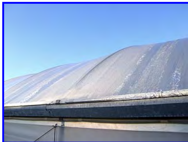
S2 ( a sinistra ) : formazione del ghiaccio sulle pareti laterali, S1 ( a destra) assenza di ghiaccio sulle pareti laterali perché l'acqua è captata dalla grondaia.
